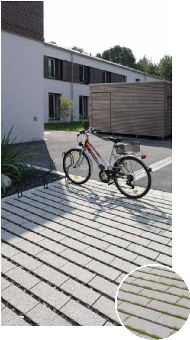
Ausdrucksstarke Akzente mit aufgeweiteten Fugen an der Steinlängsseite. Die Fugen können mit Splitt befüllt oder begrünt werden. Ein nahtloser Übergang zu Vista ist möglich.
