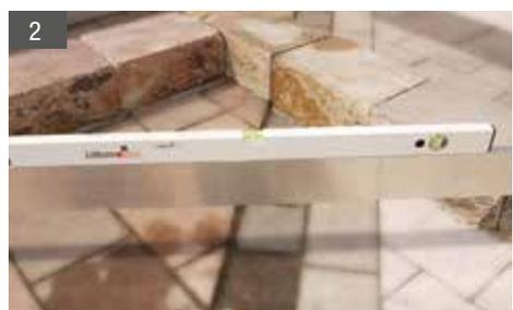
Nach dem Versetzen der ersten Reihe wird mit der Richtlatte die Ebenheit kontrolliert. Dabei sollte auch die Höhengleichheit über die Ecken überprüft werden (Abb. 2).
